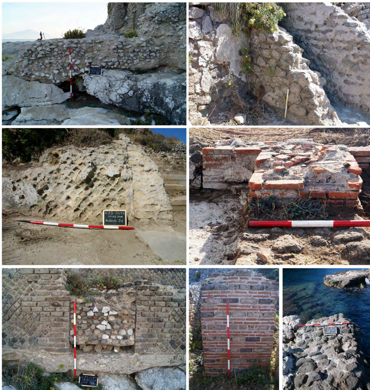
Fig. 9. Tecniche edilizie sulla pars maritima : muri di fondazione con caementa di calcare, opus incertum , opus reticulatum in tufo giallo napoletano (TGN), opus latericium , opus reticulatum in tufo grigio locale (ignimbrite campano), opus listatum , muratura della fortificazione post-antica (aragonese?) in tufo grigio locale (ignimbrite campano).
